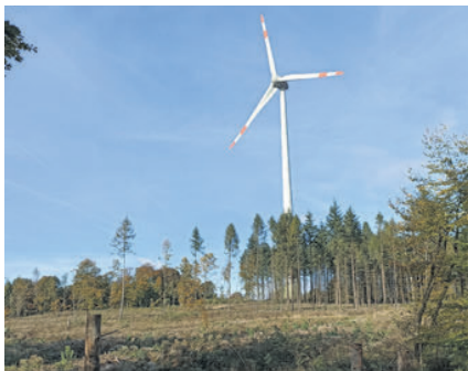
Windkraftanlage im Kalamitätsgebiet Bad Endbach (Aufnahme vom 17. Oktober 2021)
