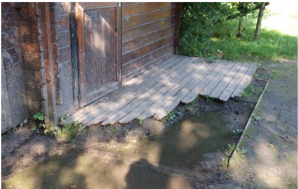
Ansicht 140: Kita Sachsenhausen. Tiroler Straße. Frankfurt am Main. Aufnahme vom 11. Juli 2012.
