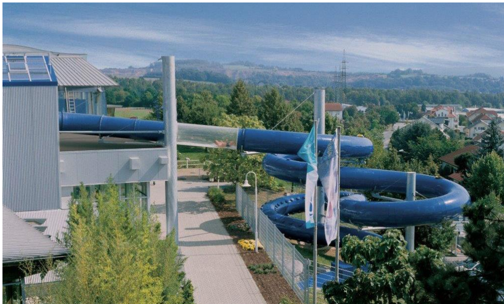
Ansicht 131: Aßlar. Außenansicht Freizeitbad „Laguna“. Aufnahme der Stadt Aßlar.
