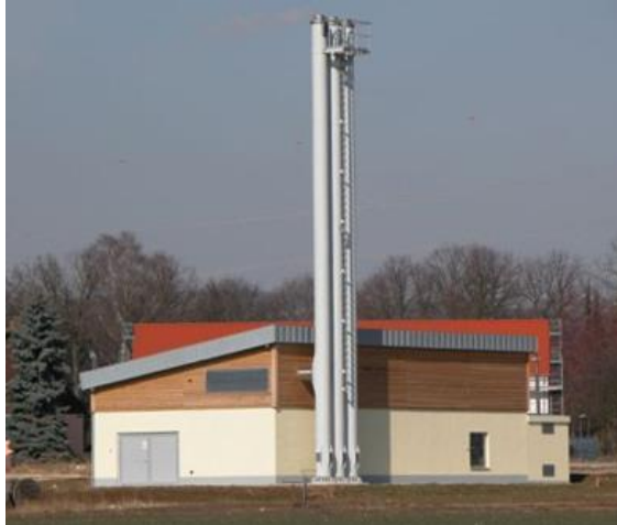
Ansicht 190: Heizzentrale Neubaugebiet Südwest. Aufnahme der Stadt Hattersheim vom Januar 2011.
