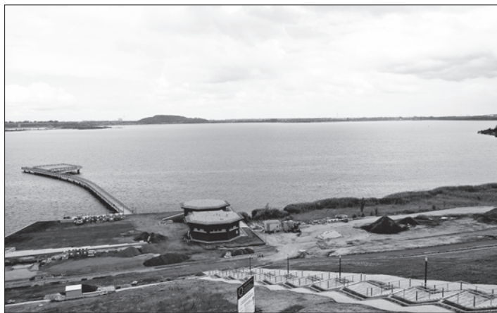
„Masterplan Geiseltalsee“: Unter diesem ambitionierten Titel soll Deutschlands größter künstlicher See mit Steuergeld erschlossen werden, und das, obwohl es sechs Kilometer weiter schon 200 Schiffs Liegeplätze gibt.
