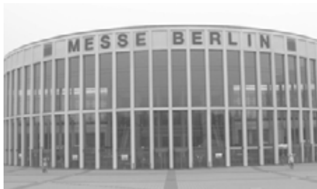
Neue Räumlichkeiten für die Messe Moderner Staat auf dem Berliner Messegelände Foto: DHV
