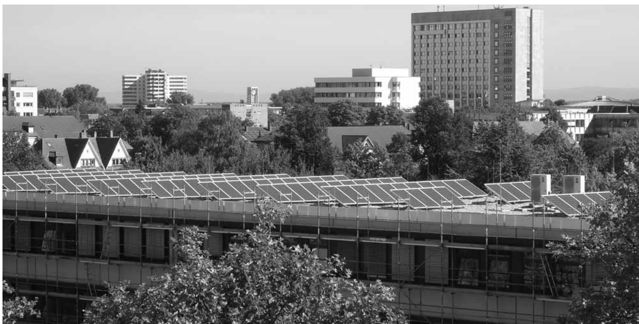
Über den Dächern von Speyer: An der DHV Speyer umweltfreundliche Stromerzeugung mit der Kraft der Sonne
