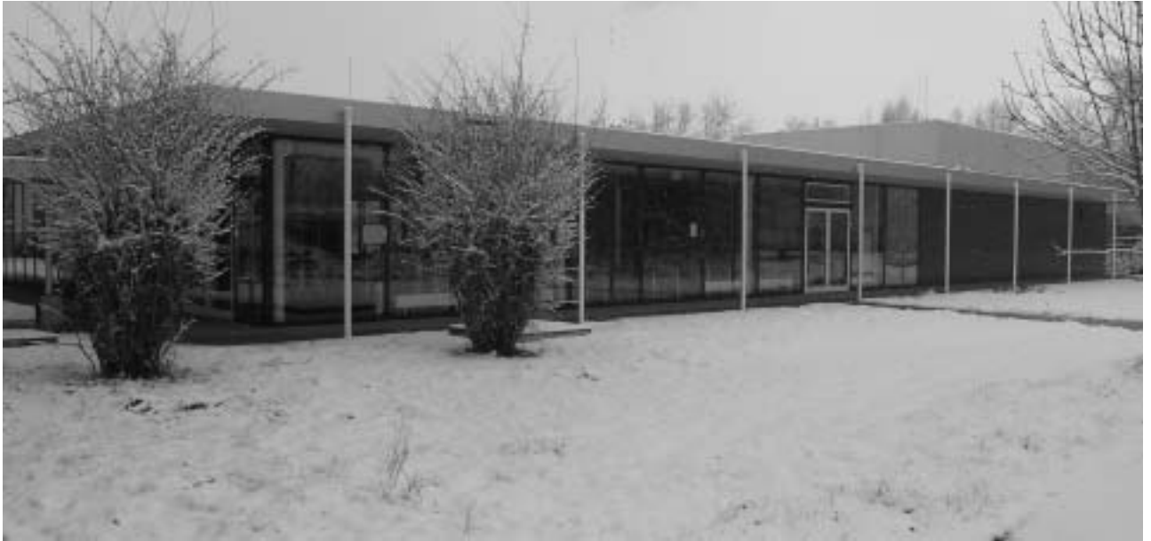
Ein eher seltener Anblick: Die verschneite Taberna nach Abschluss der Sanierungsarbeiten
